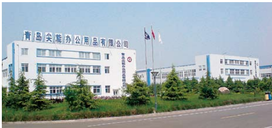
青島工場外観写真(左建屋：第一工場 右建屋：第二工場)
